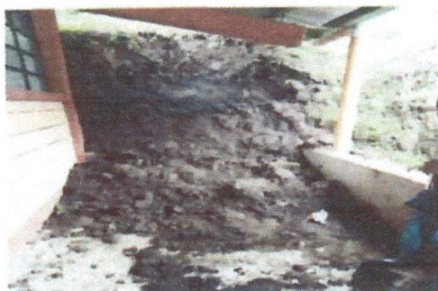
Foto 11: mantenimiento de muro de aula con excavacion, lavado, alisado, impermeabilizado y sellado.
