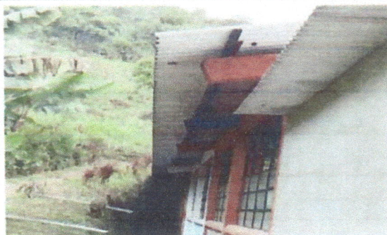
Foto 8: Colocacion de canal de lamina con su respetivo pescante y dos bajadas de agua pluvial parte de atras
