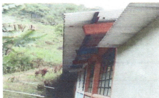
Foto 10: levantado de muro de block de piedra 0.20x0.40 x0.15 clase B expuesto para nivelar la pared de direccion
