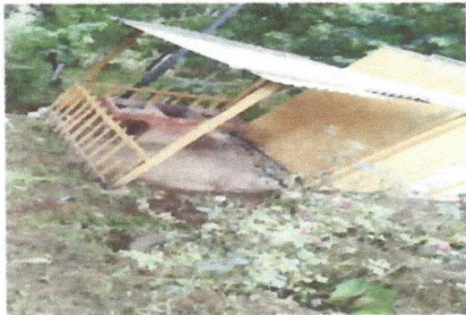
Foto 1: Cambio de cubierta de lamina acanalada por troquelada calibre 26 en dos ambientes direccion y pila.
