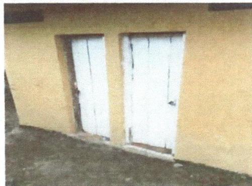
Foto 4: cambio de dos puertas de madera por metal de 0.8 x2.10 para el servicio sanitario.
