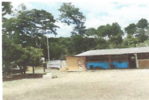
Foto 2: cambio de estructura metalica de la direccion para nivelar y agregar un corredor con costanera de 2*4 chapa 16
