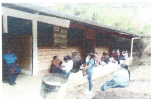
Foto 7: cambio de canales y bajadas de agua parte de enfrente y atras
